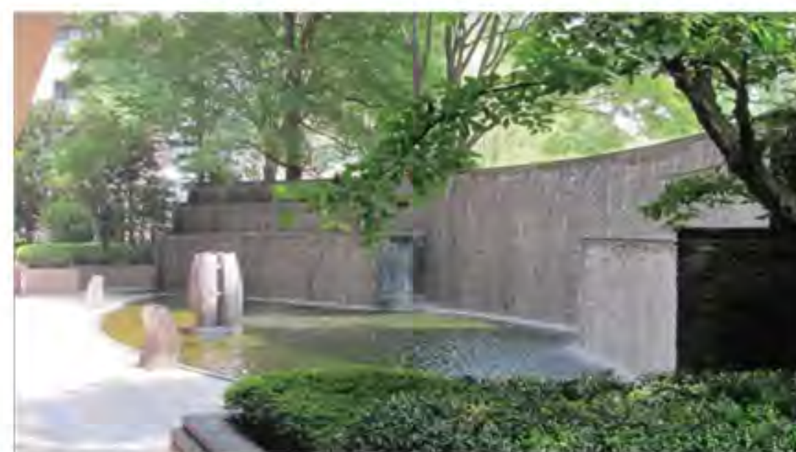
河川修景施設の現地調査
