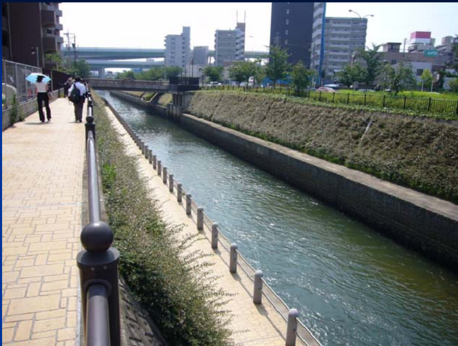
志賀橋付近の遊歩道
