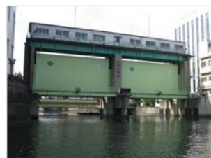
日本橋水門（亀島川）
