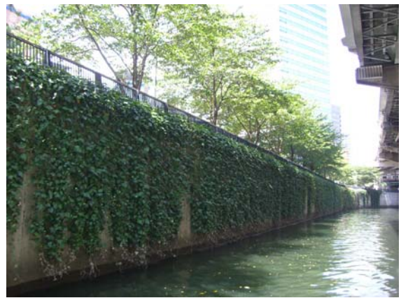
護岸緑化の状況
