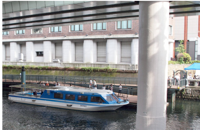
日本橋船着場完成（停泊するカワセミ号）
