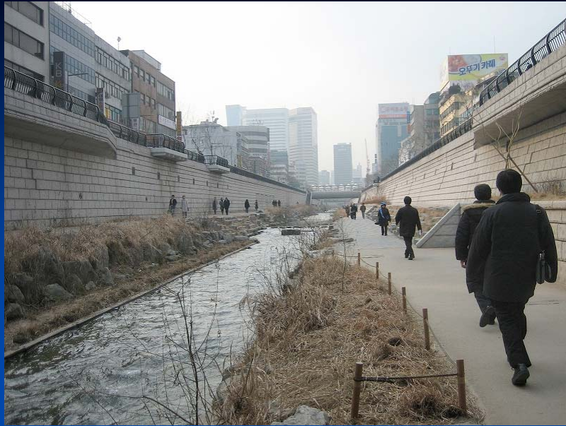
河道内の様子
