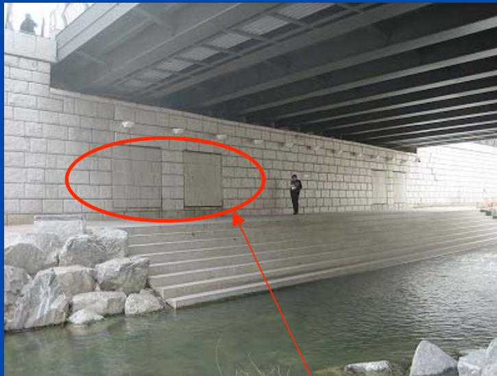
合流式下水道の雨水吐(護岸の各所に設置されている)
