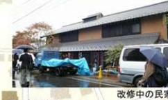
改修中の民家
