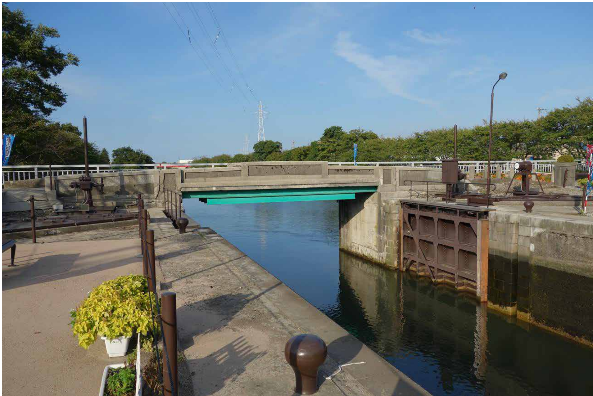
富岩運河 中島閘門
